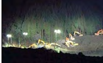
照明車による照明
