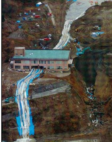
天然ダムポンプ排水
