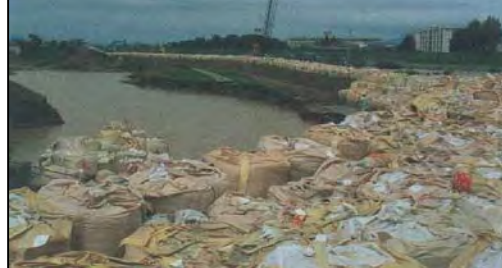
堤防決壊部応急仮締切
