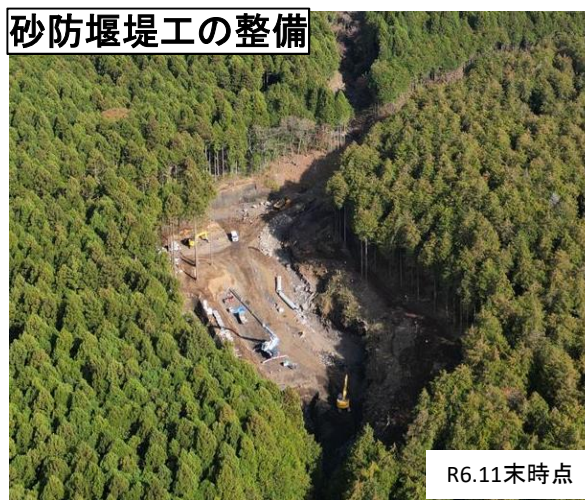
風祭上流第2堰堤工群 (静岡県富士宮市山宮地先)
