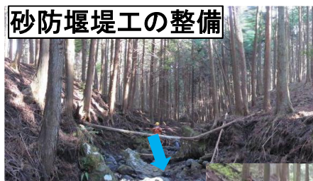
久遠寺第5堰堤 計画箇所
