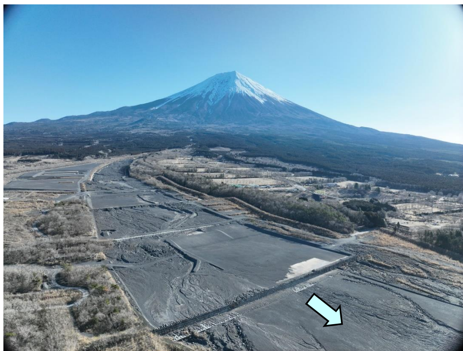
大沢川遊砂地工の堆砂土砂の撤去 （静岡県富士宮市上井出地先）
