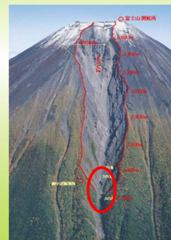
源頭部対策工事現場
