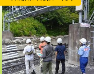
岩樋観測所(大沢川遊砂地上流)
