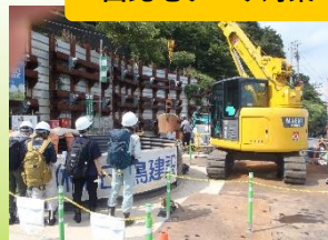
由比の工事現場見学
