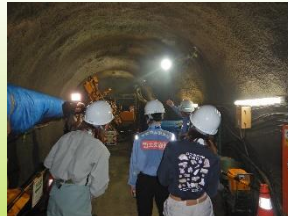
排水トンネル工事の見学
