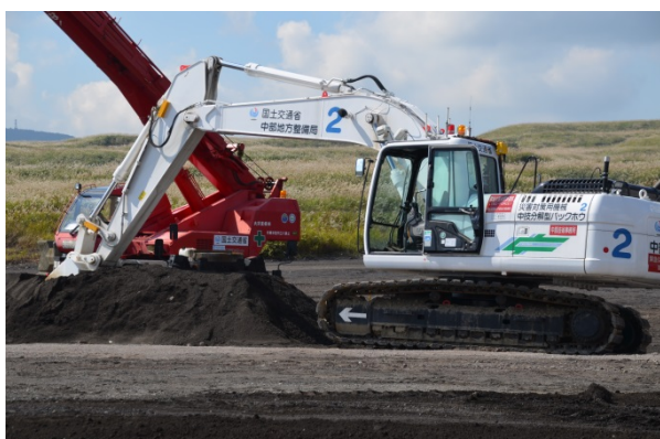
遠隔式バックホウによる掘削
