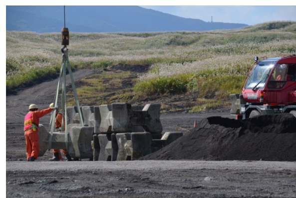
導流堤の施工
