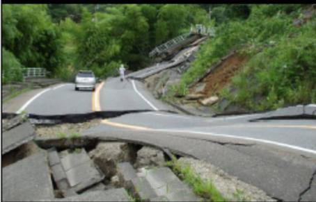
地震による道路陥没箇所の原因調査
