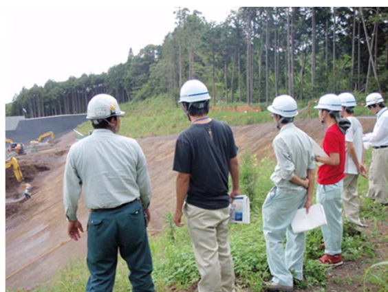
砂沢沈砂地にて工事担当者より説明
