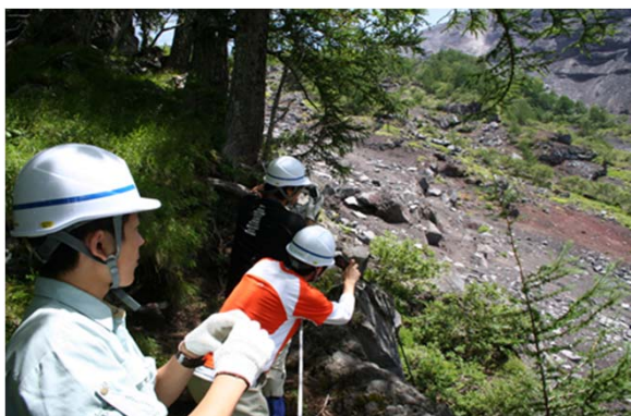
大沢崩れと大沢川源頭部対策工事を学ぶ
