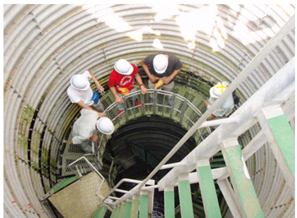
由比地すべり対策工事で集水井の中へ
