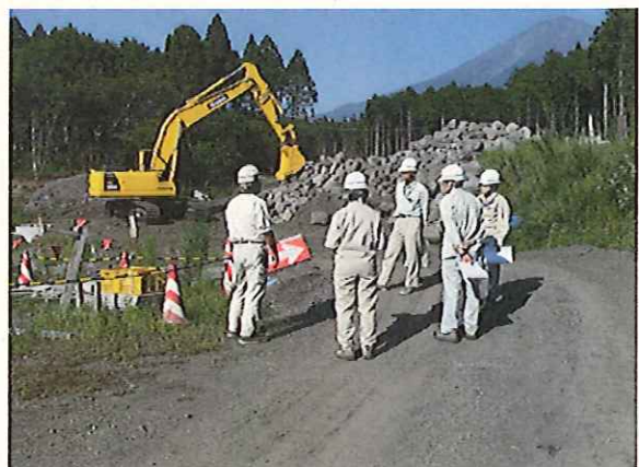
大久保沈砂地にて工事担当者より説明
