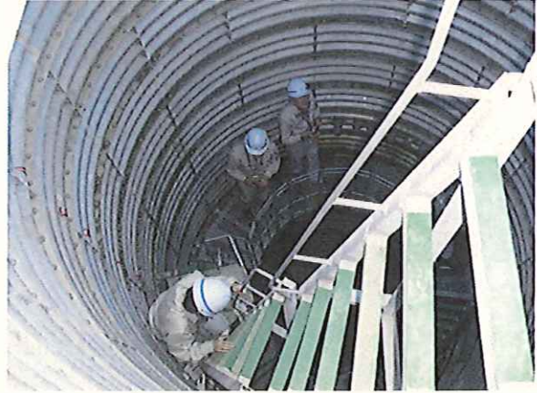
由比地すべり対策工事現場において 集水井の中へ
