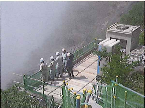
大沢川源頭部対策工事にて施工方法を学ぶ
