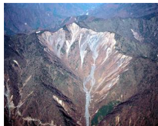
14 安倍川大谷山腹工
