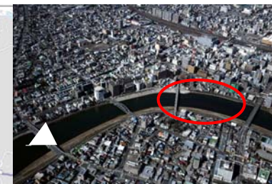
1 下河原地区河道掘削
