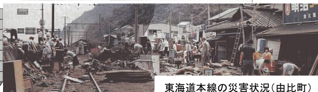
東海道本線の災害状況(由比町)
