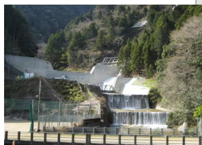
34 天竜川水系河内沢川砂防えん堤
