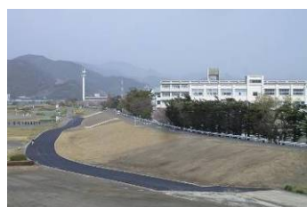
9 安倍川左岸堤防補強工
