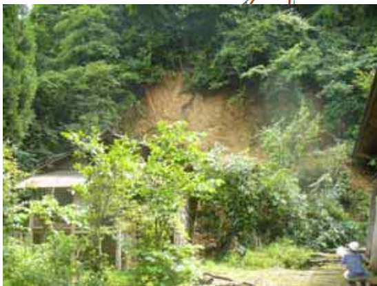
危険箇所点検の状況(7/21)
