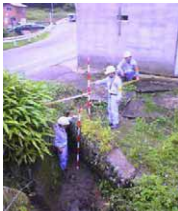
危険箇所点検の状況(7/20)
