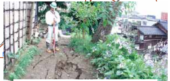
危険箇所点検の状況(7/19)
