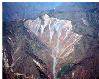
12 安倍川大谷山腹工
