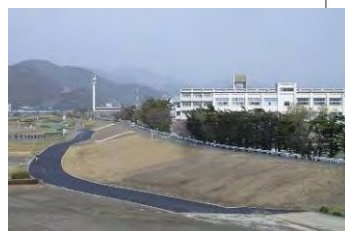
10 安倍川左岸堤防補強工
