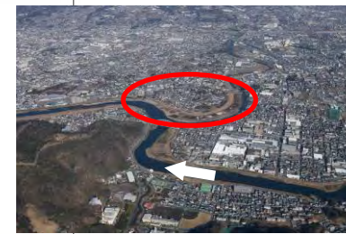
7 木瀬川排水樋管
