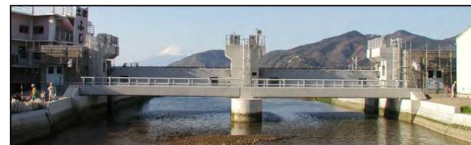
17 八木沢大川水門工(地震高潮対策)
