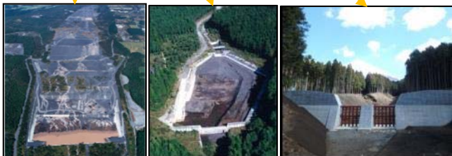
大沢川における対策 風祭沈砂地 春沢第1堰堤
