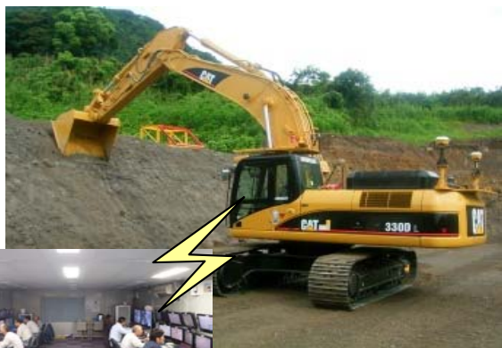
長距離遠隔操作による無人化施工 (雲仙岳の事例)
