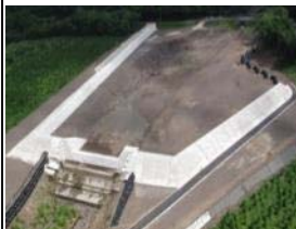
遊砂地の施工
