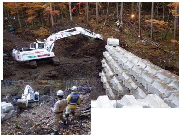
ブロック積み作業 (H26御嶽山の事例)
