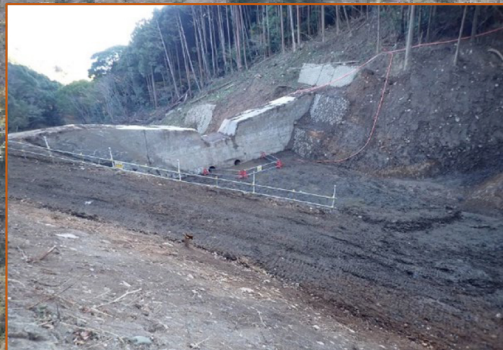
逢初川砂防堰堤(既設)の除石
