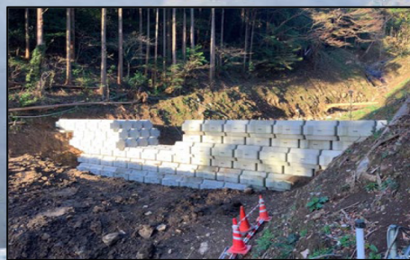
仮設ブロック堰堤
