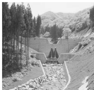
砂防堰堤の例
