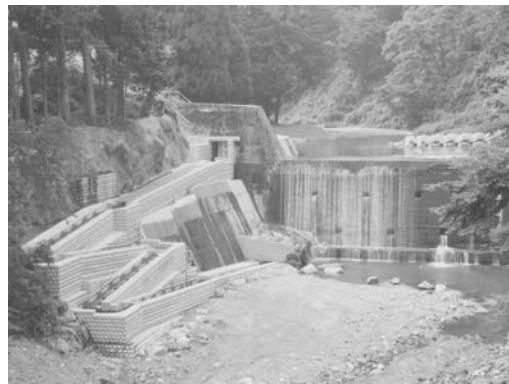
魚道を設置した堰堤の例
