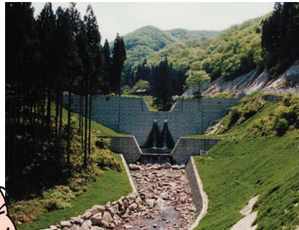
和佐谷第1砂防堰堤 (揖斐川町久瀬日坂地先)
