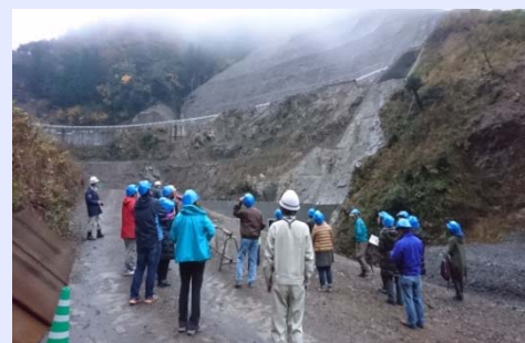
高地谷第1砂防堰堤工事現場
