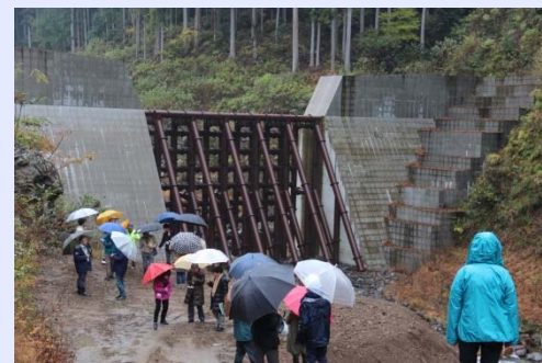
大蔵谷第1砂防堰堤
