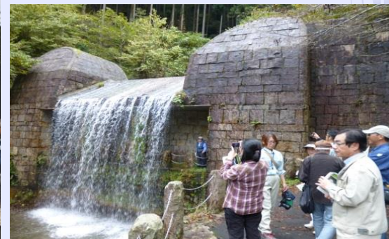
鷲巣谷第1砂防堰堤
