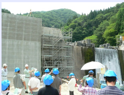
品又谷第1砂防堰堤工事現
