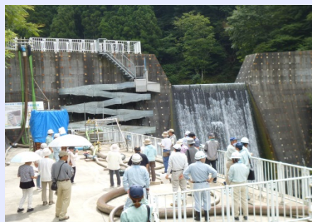
山の谷第1砂防堰堤
