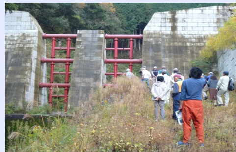
宇津志谷第1砂防堰堤
