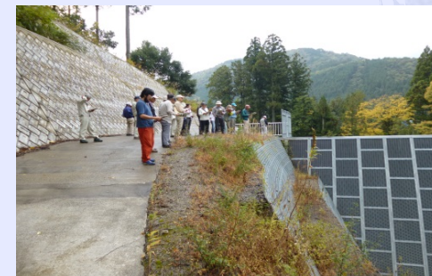
敷原谷第1砂防堰堤
