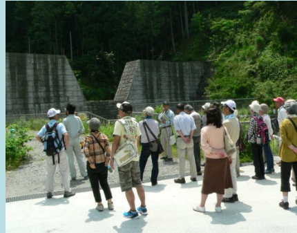
<下谷第1砂防堰堤見学>
