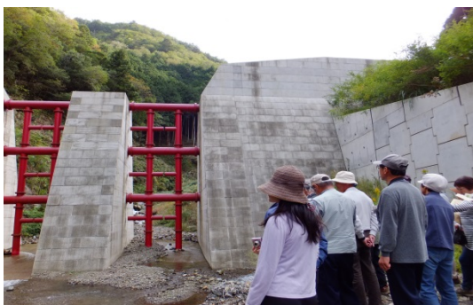
＜宇津志谷第1砂防堰堤＞
