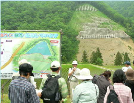
<八草川山腹工工事見学>
