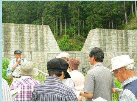
<下谷第1砂防堰堤見学>
