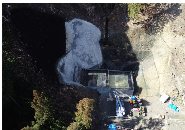
ガラン谷施工状況 2020年2月現在
