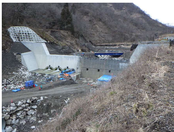
ナンノ谷砂防ダム3号 施工状況 2020年2月現在
