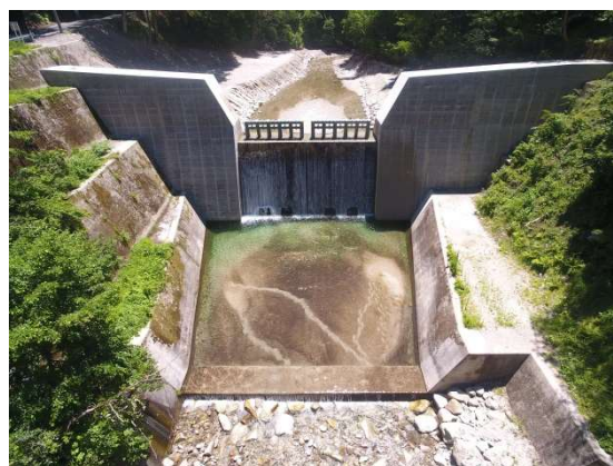
品又谷第2砂防堰堤 2018年2月流木止め設置
