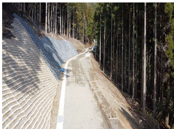
施工状況 2020年2月現在
