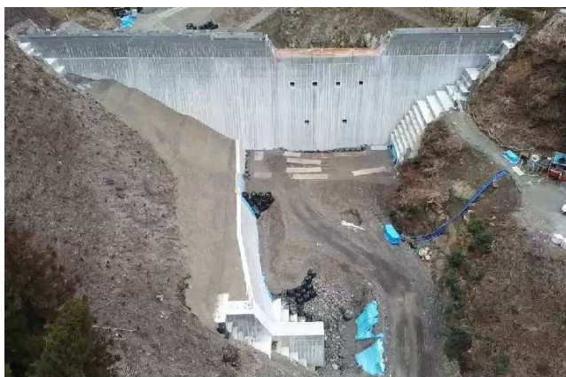
施工状況 2020年2月
