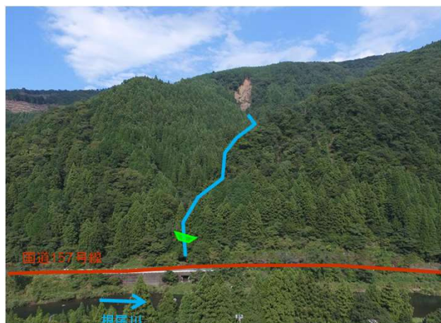
根尾川右岸より蛇抜谷を望む
