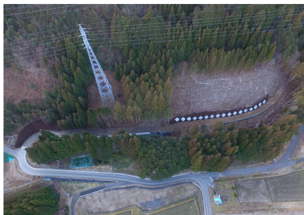
施工状況 2020年2月現在
