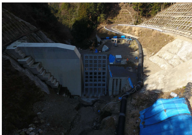
施工状況 2020年2月現在
