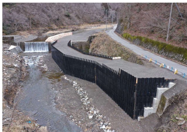
ナンノ谷砂防堰堤1号付近切廻し道路 施工状況 2020年2月現在
