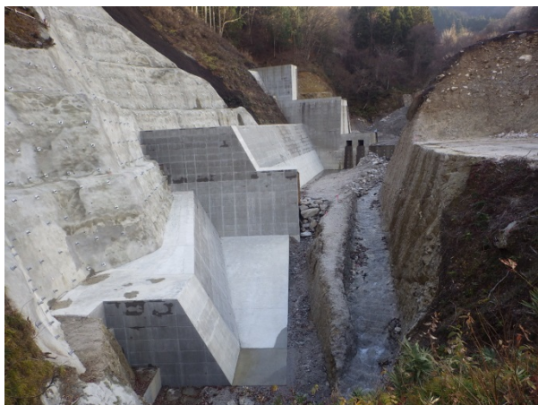
施工状況 2018年12月現在
