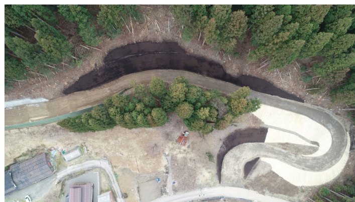
ガラン谷施工状況 2019年3月現在
