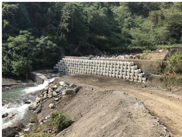
下流側応急対策完了(2018年9月)
