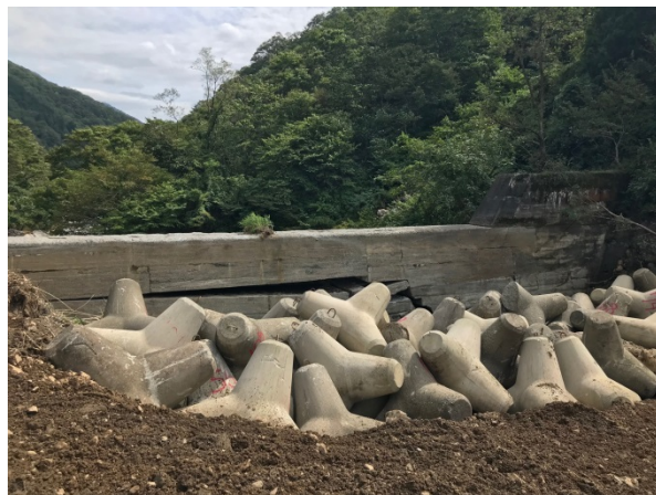
上流側応急対策完了(2018年9月)
