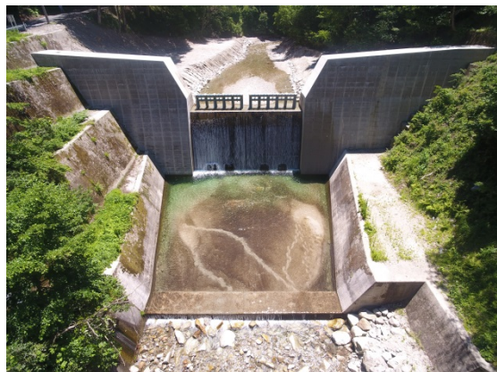
品又谷第2砂防堰堤 2018年2月流木止め設置
