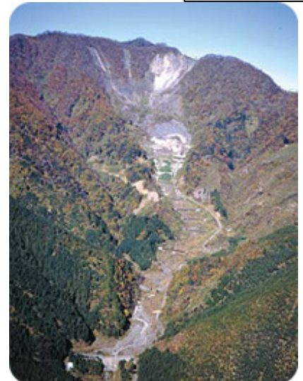
根尾白谷大崩壊地
