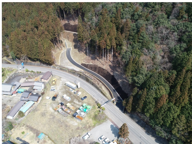
アテガ平谷施工状況 2019年3月現在
