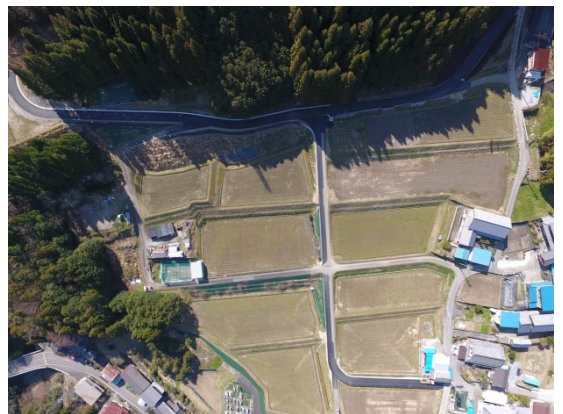
施工状況 2019年3月現在
