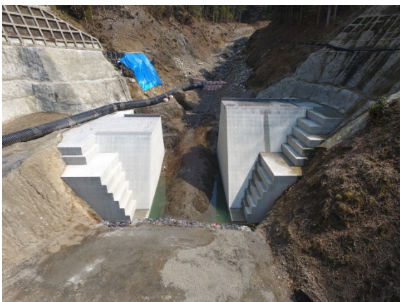
施工状況 2019年3月現在
