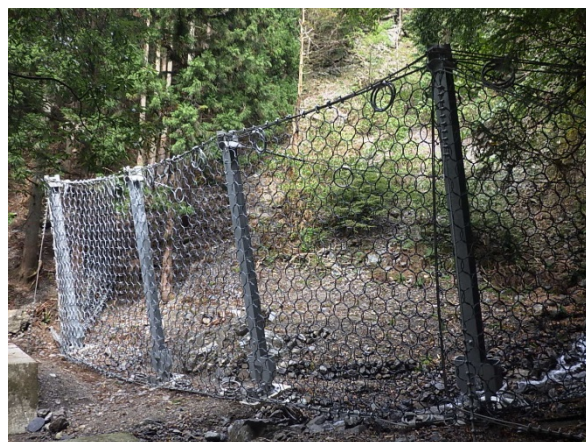
施工状況 2018年10月現在
