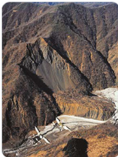
徳山白谷大崩壊地
