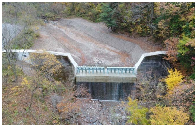
施工状況 平成29年12月現在
