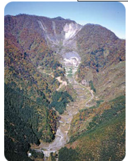
根尾白谷大崩壊地
