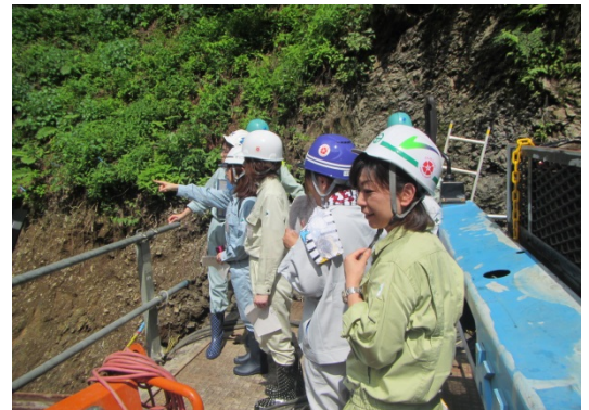
工事現場パトロール (平成29年7月)
