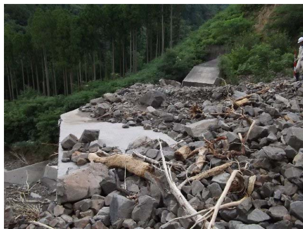
平成23年1月 土石流 (本巢市根尾越波) (2011年)
