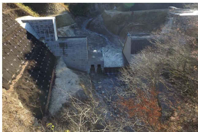
施工状況 平成29年11月現在
