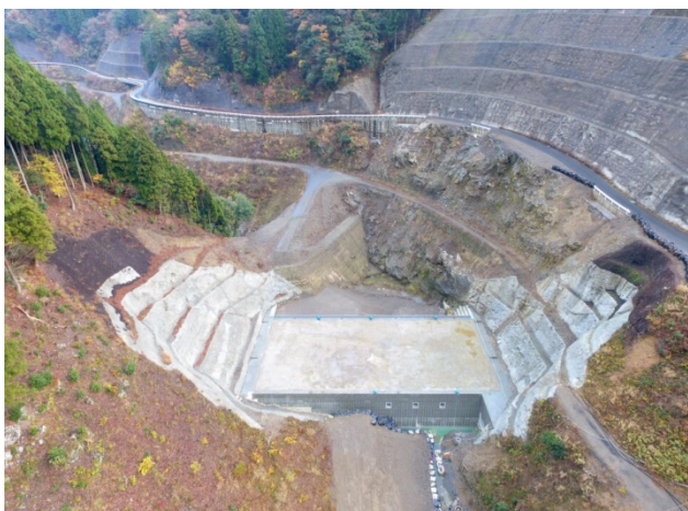
本堤の整備状況(平成29年12月)
