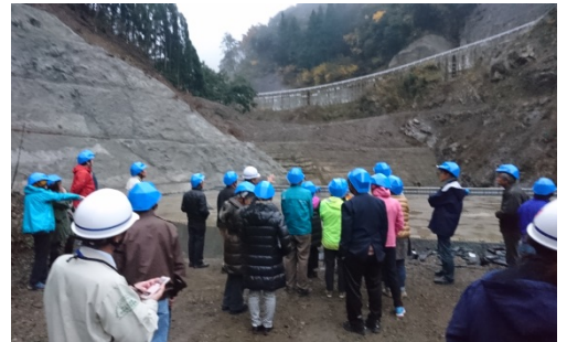
建設中の砂防堰堤の見学する様子 (平成29年11月)
