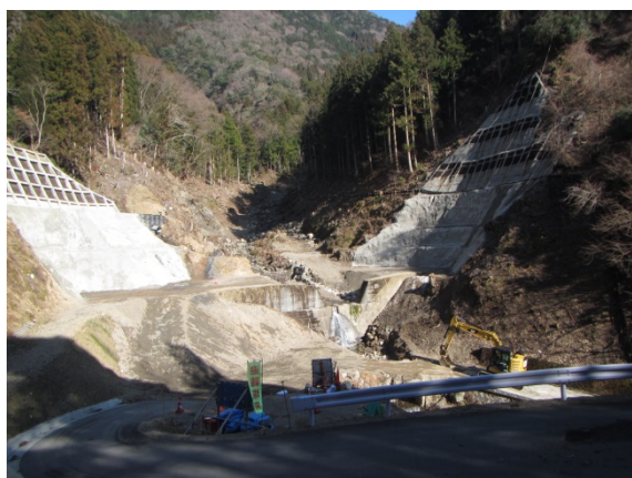
施工状況 平成30年3月現在
