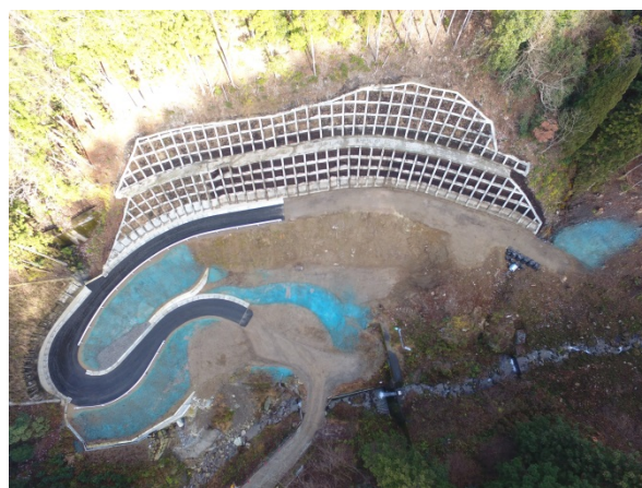
施工状況 平成29年2月現在
