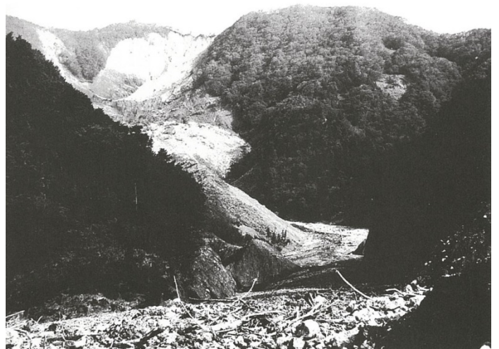
根尾白谷大崩壊地
