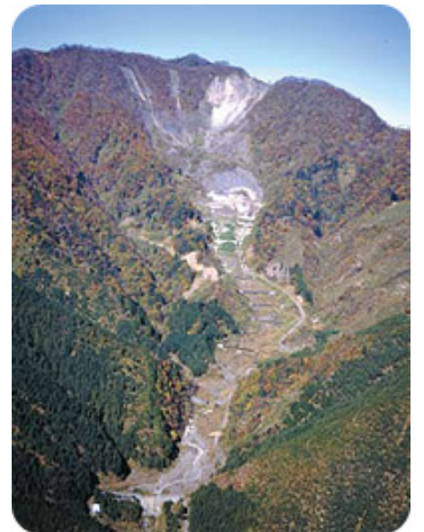
根尾白谷大崩壊地
