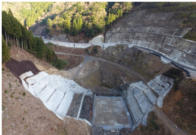
本堤の整備状況
