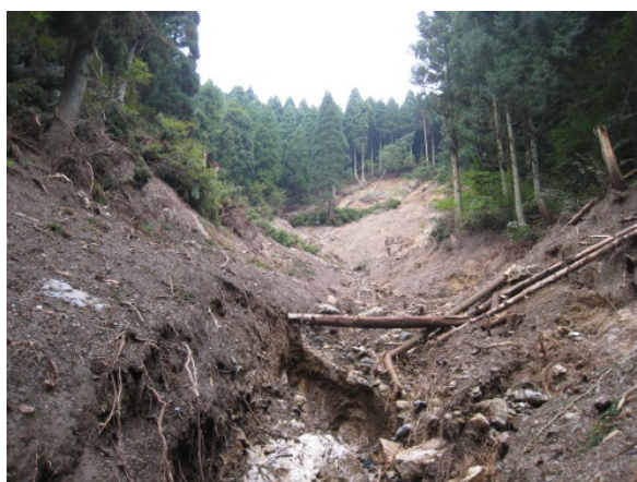
大量の流木・土砂が流出し、国道303号まで流出
