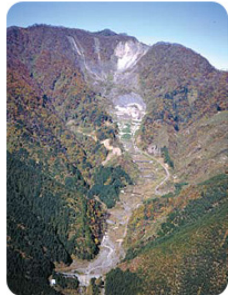
根尾白谷大崩壊地
