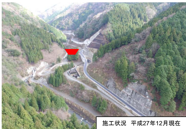
付け替え道路の整備状況
