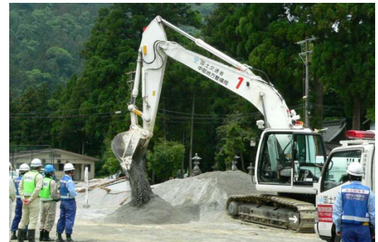
遠隔操縦式バックホウによる土砂撤去 (平成27年5月 操作訓練の様子)
