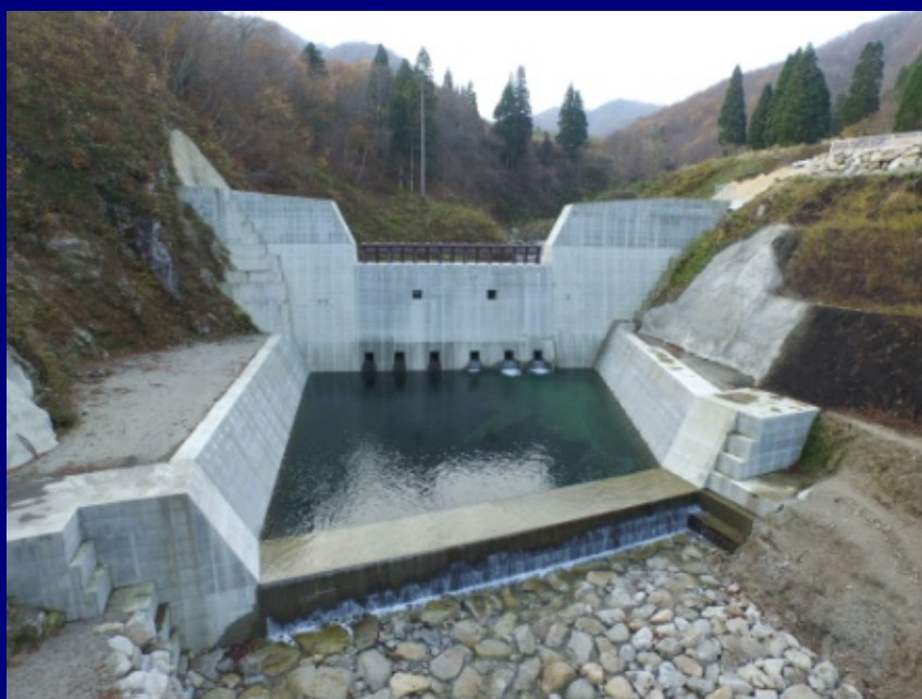
地谷第二砂防堰堤(平成27年度完成)
