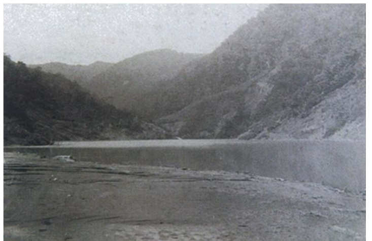
ナンノ谷大崩壊による崩落土砂(153万 m^3 )により湛水、決壊し、下流の家屋23戸が流出
