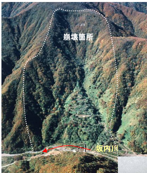
ナンノ谷大崩壊(明治28年発生)
