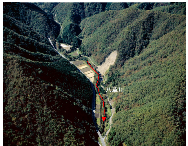
坂内川上山腹崩壊(平成22年1月発生)
