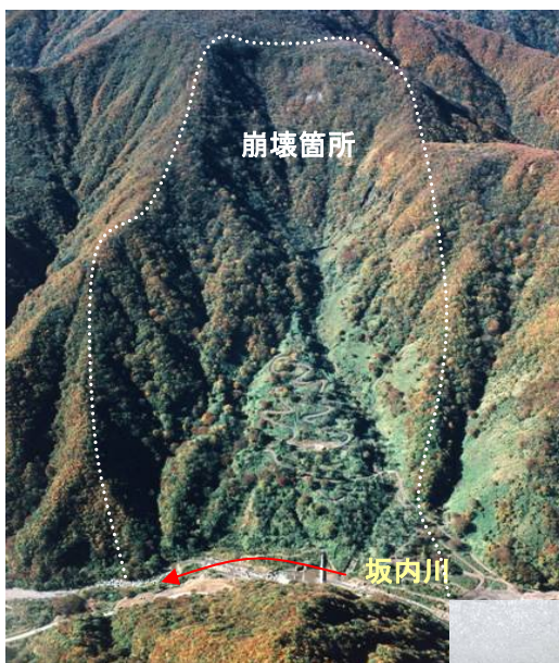
ナンノ谷大崩壊(明治28年発生)
