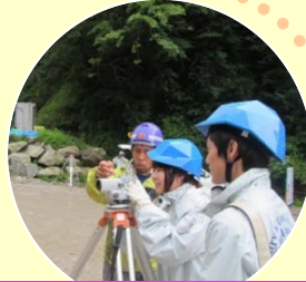
現場体験：測量作業 (地谷第2砂防堰堤工事現場)
