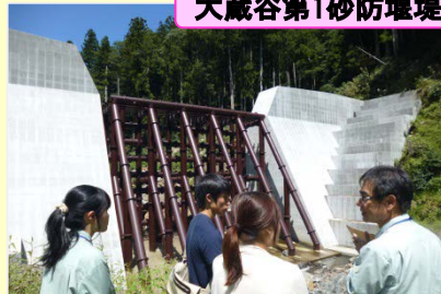
大蔵谷第1砂防堰堤
