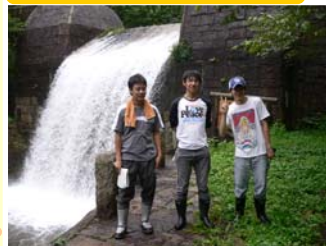
鷲巣谷第1砂防堰堤
