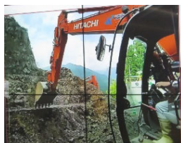
MC掘削状況
