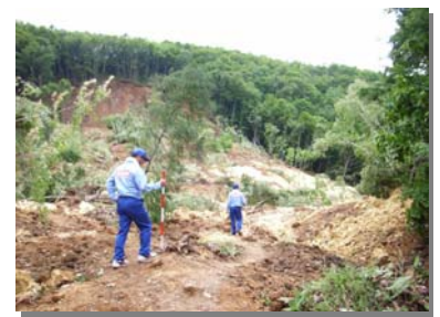
地すべり現場
