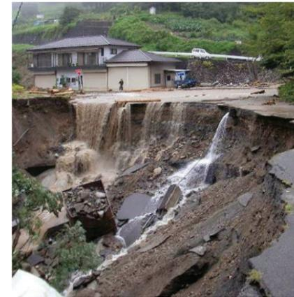
土石流により国道303号寸断
