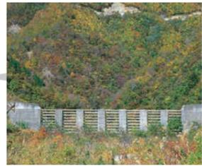
管内で最初となる透過式の砂防堰堤でした。
