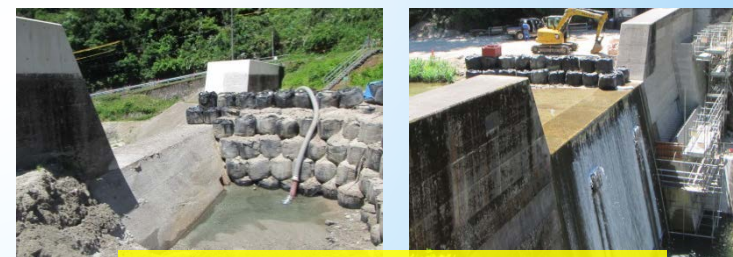
品又谷第1、第2砂防堰堤 工事現場
