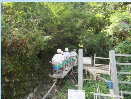
現場作業で使うモノレールに乗り 工事現場の最上部まで移動
