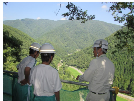
現場で働く若手技術者の声を聞く （八草山腹工事）
