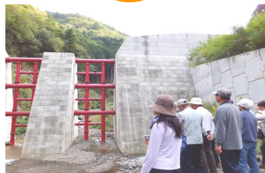
宇津志谷第1砂防堰堤
