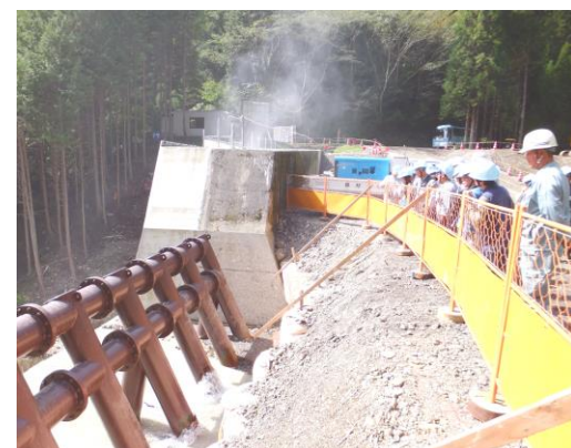
流木対策工事現場(根尾上葛谷)
