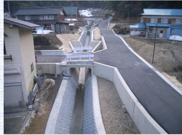
ドン谷溪流保全工
