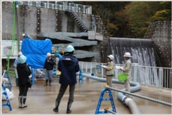
既設砂防堰堤において呼び水サイフォン排水装置を使用した小水力発電実験 (山の谷第1砂防堰堤)
