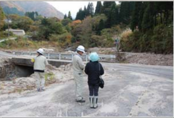
台風16号による橋梁閉塞箇所 (品又谷【揖斐川町坂内坂本地先】)
