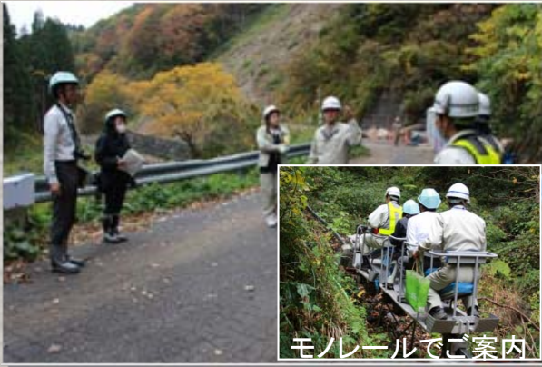
復旧工事が進む山腹崩壊箇所 (八草川山腹工事)
