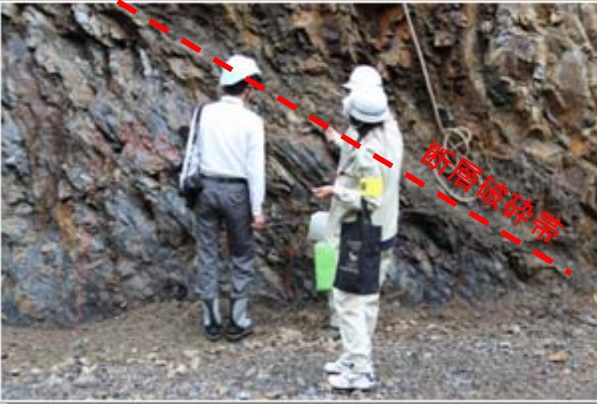
切り土面に現れた断層破砕帯を見学 (大蔵谷第1砂防堰堤道路工事)
