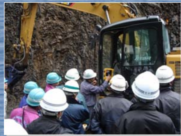
MGバックホウ掘削
