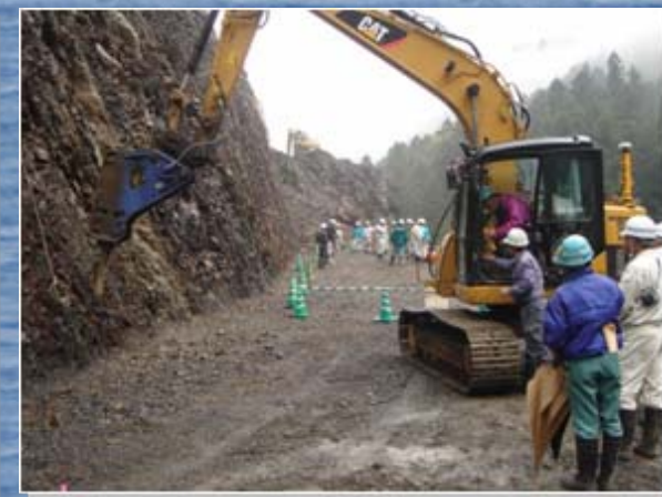
MGバックホウ掘削
