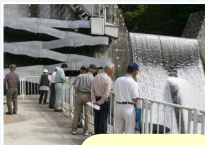
山の谷第1砂防堰堤見学
