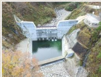
完成した地谷第2砂防堰堤
