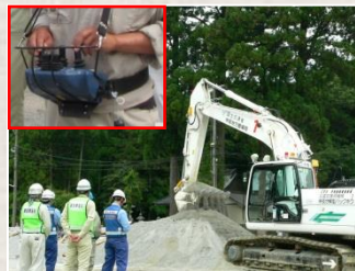
分解型遠隔操作式重機の操作
