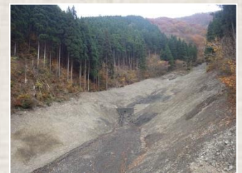
堆積土砂の撤去が完了
