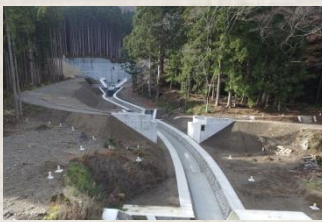
砂防堰堤・溪流保全工が完成
