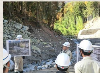
土石流発生箇所にて、当時の写真と比較して復旧状況を把握
