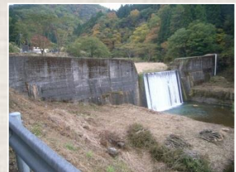
新たに流木止施設を設置する品又谷第1砂防堰堤
