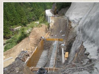
急斜面で道路造成
