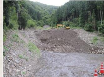
堰堤に堆積した土砂を除石(越波谷第3砂防堰堤)
