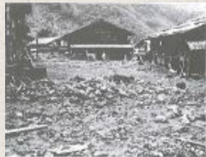
中島集落の中心を 土石流が流れ壊滅状態に陥った
