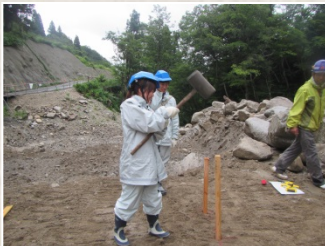
工事現場での丁張り作業を 実際に体験
