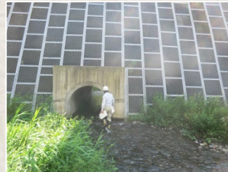
堰堤の暗渠に入り 土砂の堆積状況を確認
