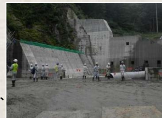
安全パトロールの様子
