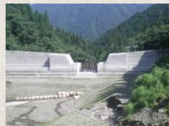
寒谷第1砂防堰堤に鋼製流木止を設置
