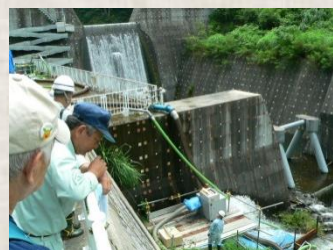
サイフォン式小水力発電の開発実験
