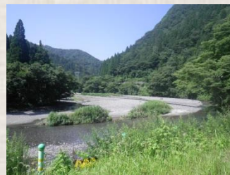
坂内砂防堰堤の上流に堆積した土砂
